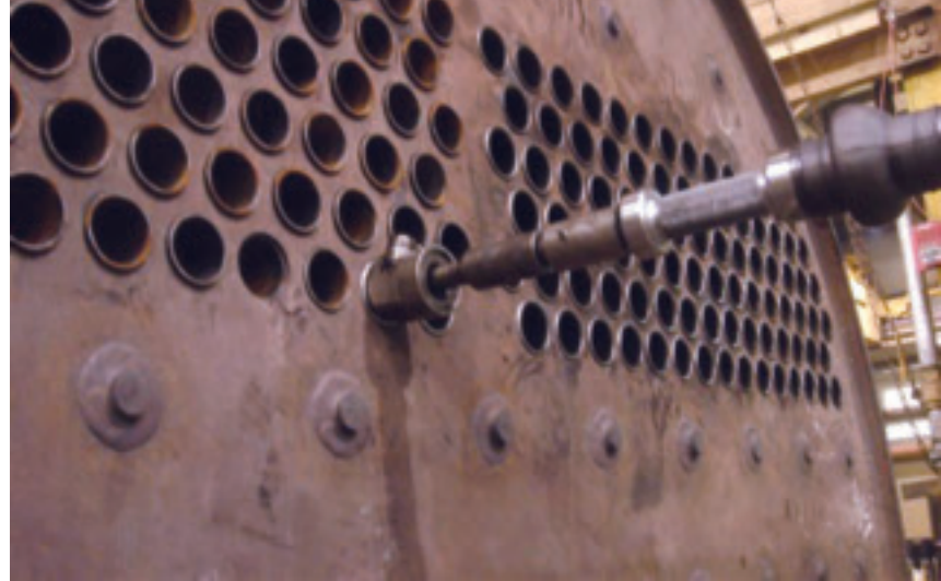
El Wils-Tronic™ con el Expansor Rebordeador
